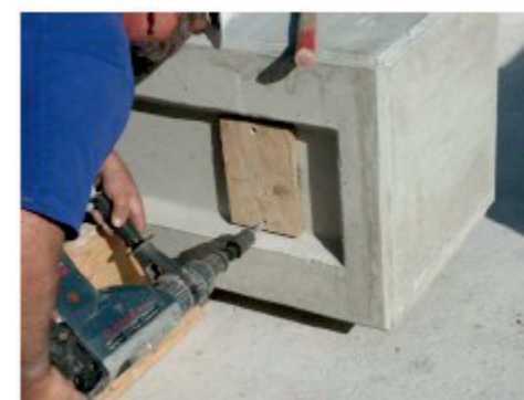
Montáž „desky podélného nosníku dole“, zde s dřevěnou vrtací šablonou.
