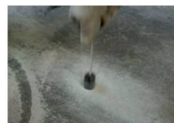
Vyvrtané otvory důkladně očistěte kartáčem
