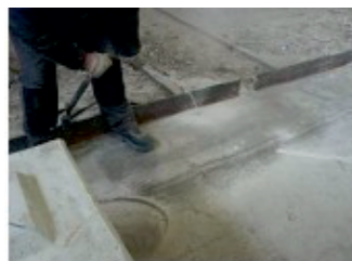
Otvory vyfoukejte prodlužovací hadicí nasazenou na kompresoru
