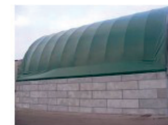
Dvojitý přesah ve vazbě zdi
