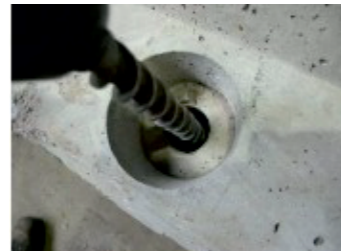
Vystředění vrtáku v otvoru
