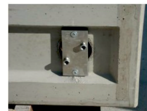
Namontované „desky podélného nosníku dole“, matice směřují dolů.
