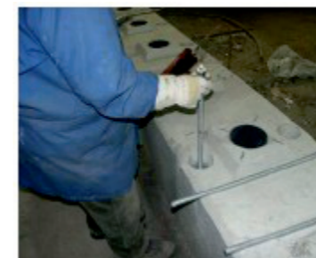
Nasazení lepené kotvy
