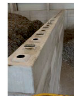
Desky podélného nosníku nahoře. Deska podélného nosníku dole je vyrovnána stejně
