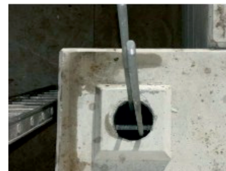
Nasazené kotevní tyče
