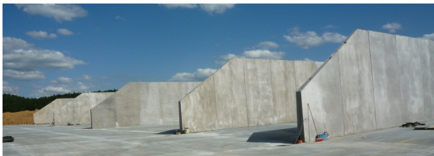
Silážní žlab Kladruby se zkosenými čelními prefabrikáty
