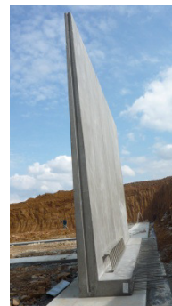
Silážní prefabrikát tvaru L o výšce 5,8m
