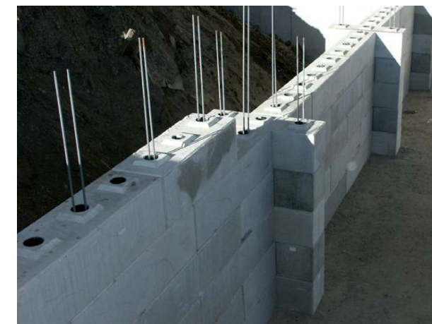
Vynikající stabilita: Bloky jsou upevněny k sobě a ukotveny
