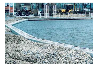
Nábřežní stěna u jezera v Rustu
