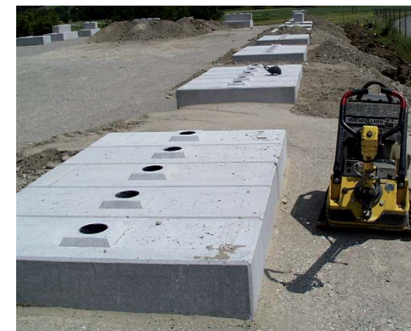
Stabilní široký základ zdi postavený z dílců quick-foundationbloc
