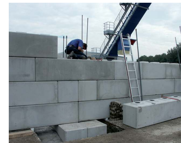
Ukotvení pomocí systému quick-foundationbloc pro dosažení vysoké únosnosti a stability
