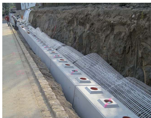
Opěrná zeď s výztužnými sítěmi
