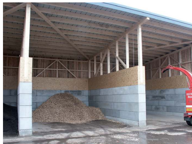
Pouze ze čtyř základních prvků postavíte skladovací boxy
