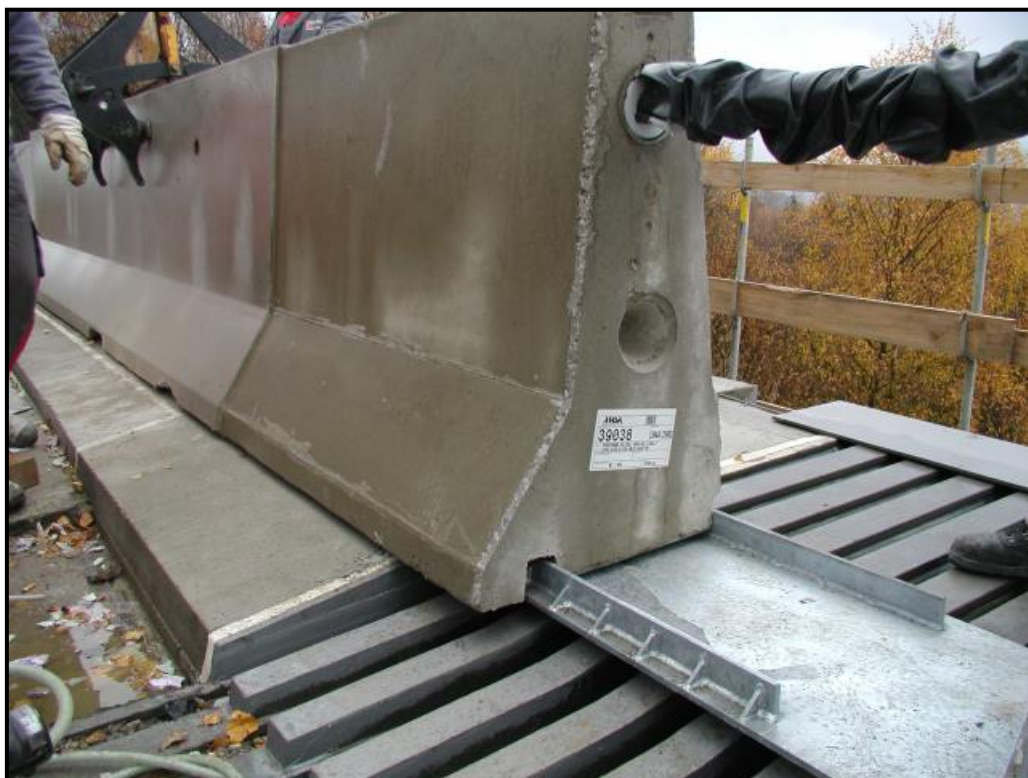
Obrázek 46 – Pohled na vodící plech u dilatace 900 mm
