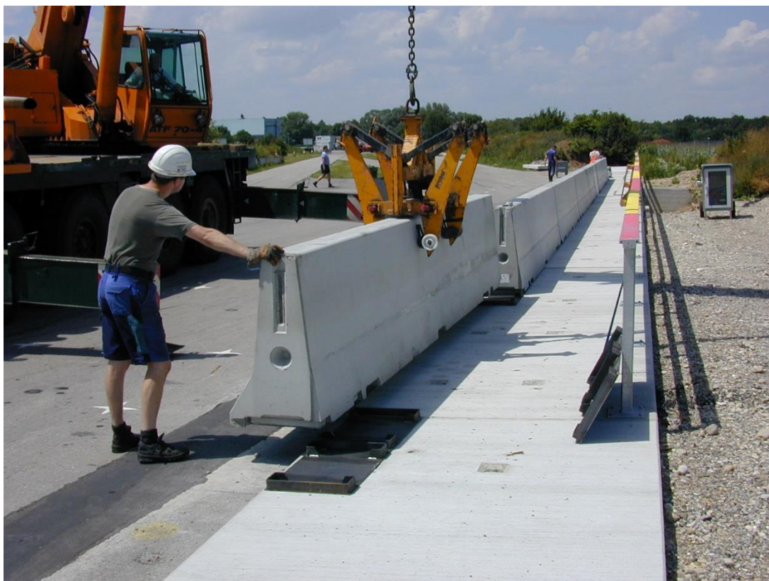
Obrázek 29 – Pohled na osazování běžného mostního dílce (platí pro oba typy)
