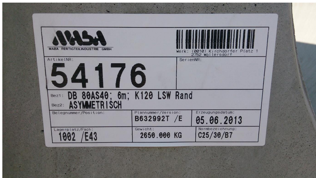
Obrázek 50 – Papírový štítek, kterým se značí svodidla Delta Bloc
