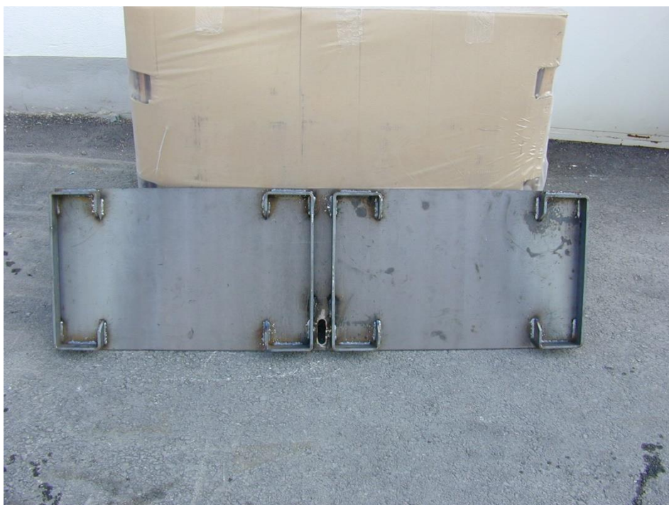
Obrázek 30 – Pohled na kotevní plech, do kterého se osazují konce každého běžného dílce obou mostních typů
