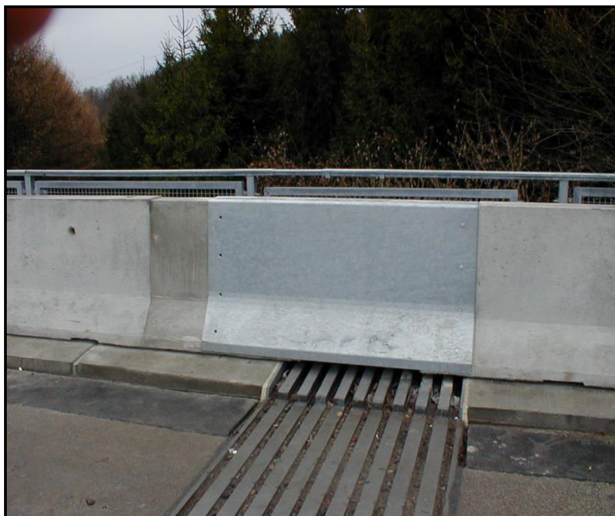
Obrázek 48 – Celkový pohled na provedenou dilataci
