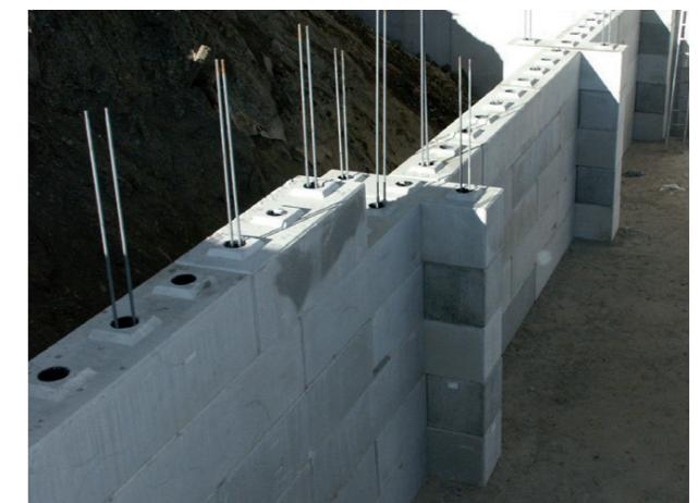
Vynikající stabilita: Bloky jsou upevněny k sobě a ukotveny
